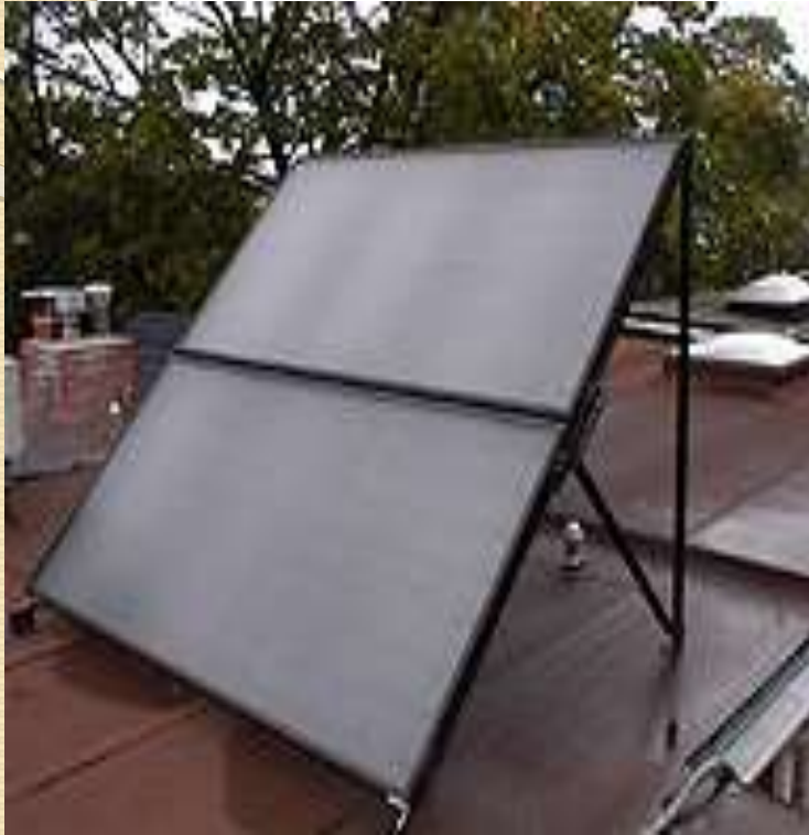
fig: Flat-plate collectors
